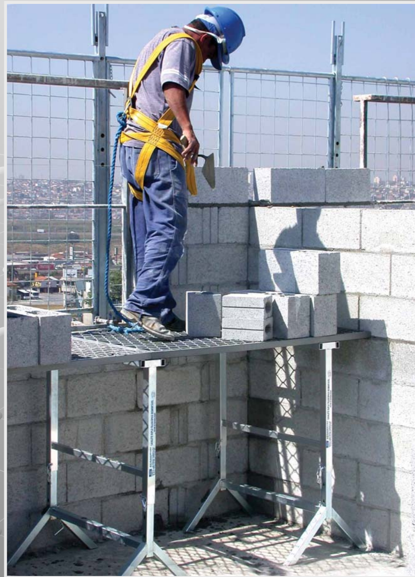
Proteção na fase da alvenaria da 5ª à ultima fiada
